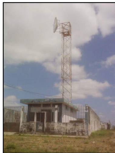
Antena de Telecomunicación CNT
