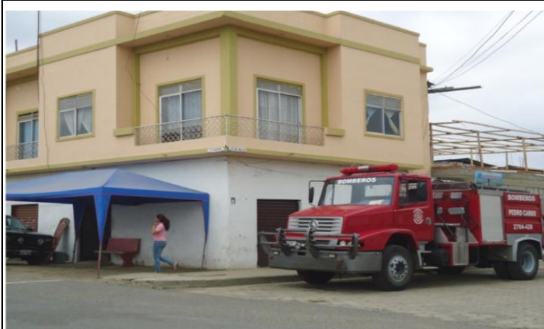
Fotografía # 31: Local provisional del cuartel de bomberos de Pedro Carbo
