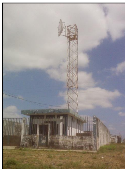
Fotografía 10 Antena de Telecomunicación CNT
