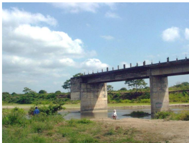
Foto 6. Construcción de puente dentro de la zona de divagación del río Pedro Carbo.
